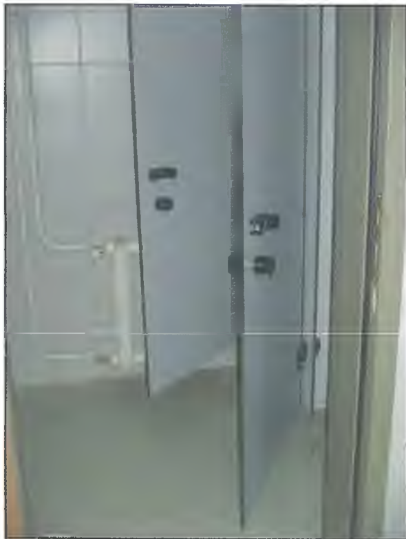
Фото С2. Санузел на I этаже (№ 14 на плане)
