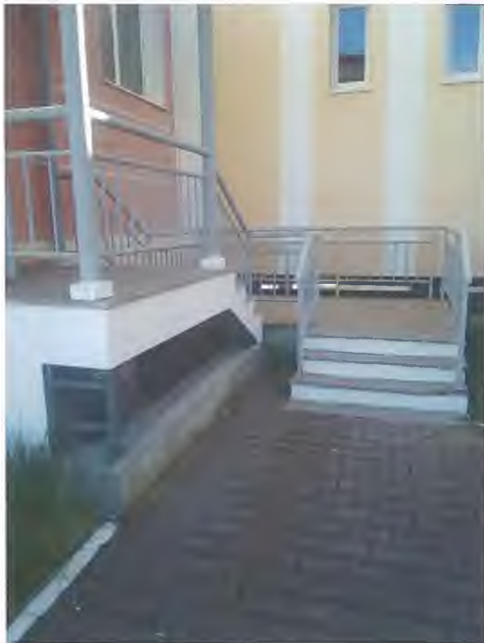
Фото П4. Лестница наружная эвакуационная
